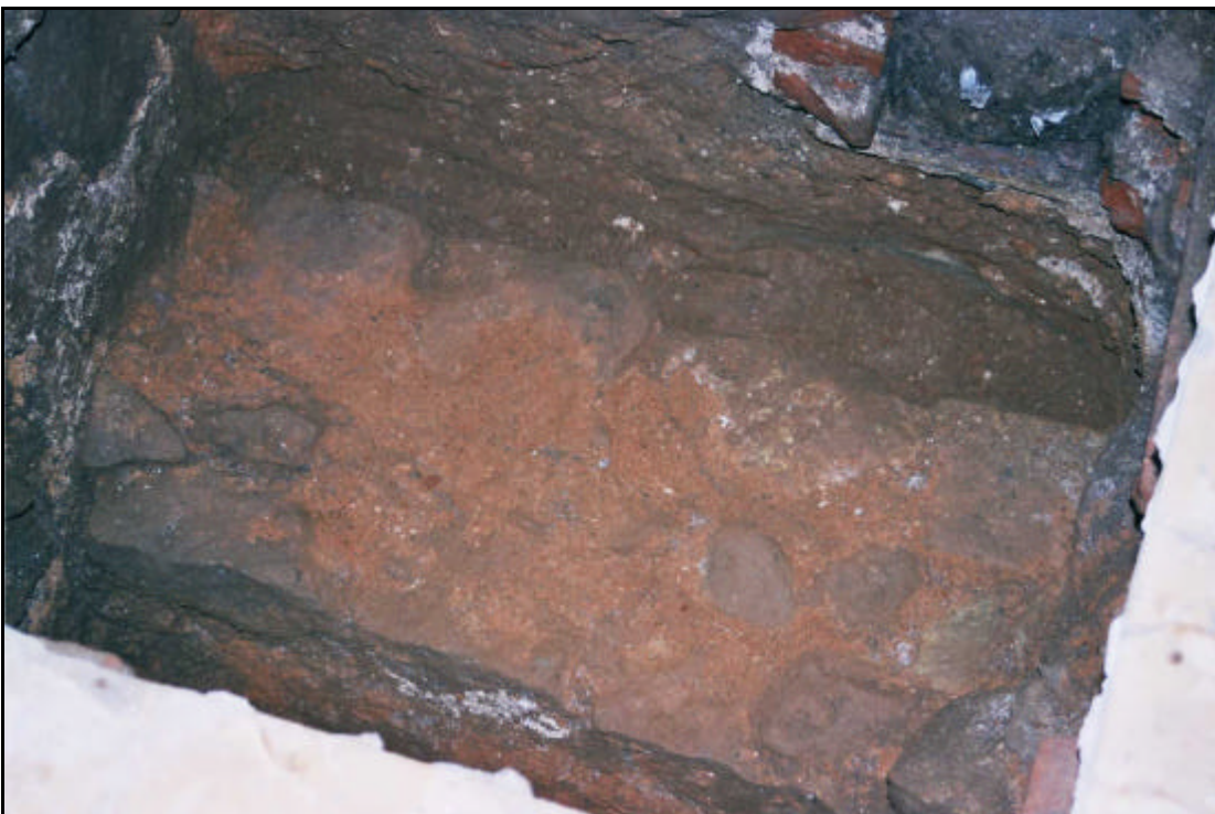
Fotografia 8. Detall mur U.E. 208.
