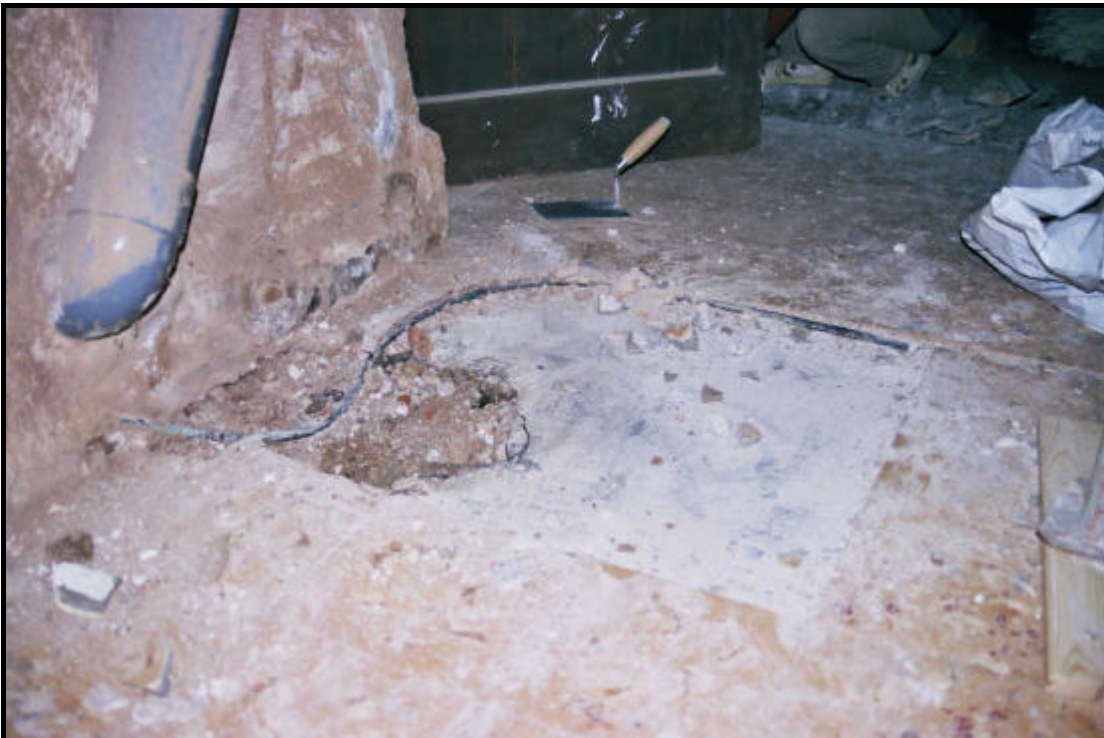
Fotografia 6. Detall arqueta on s'aprecia reparació realitzada al segle XX.
