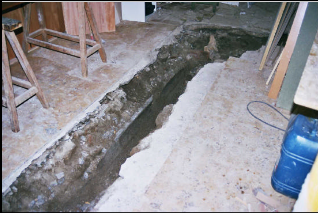
Fotografia 3. Detall del tub de clavegueram (U.E.111), el qual es va trencar per posar el nou.
