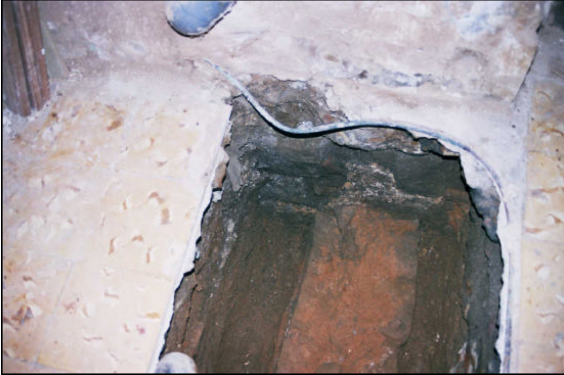
Fotografia 9. Detall mur U.E. 208.
