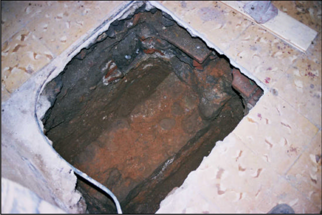
Fotografia 10. Detall mur U.E. 208.
