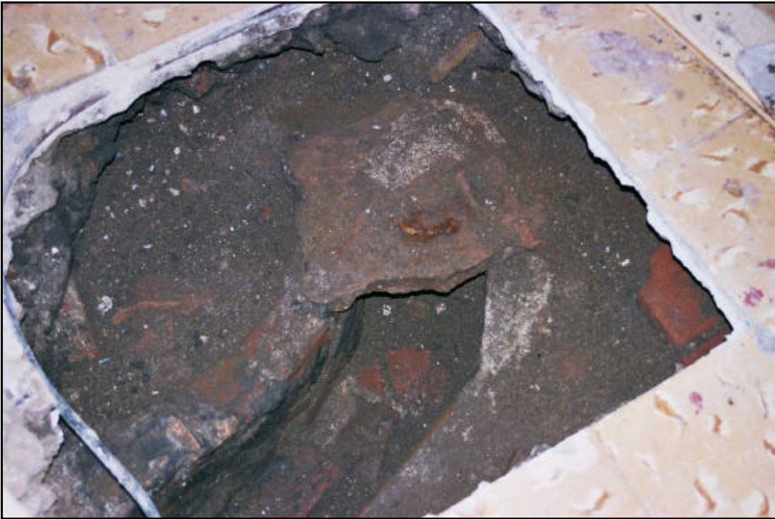
Fotografia 7. Detall claveguera U.E. 204 a una potència de 32 cms. respecte el nivell de terra.
