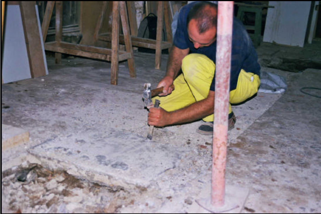
Fotografia 1. Detall de l'inici dels treballs manuals a l'arqueta del pilar de fonamentació.
